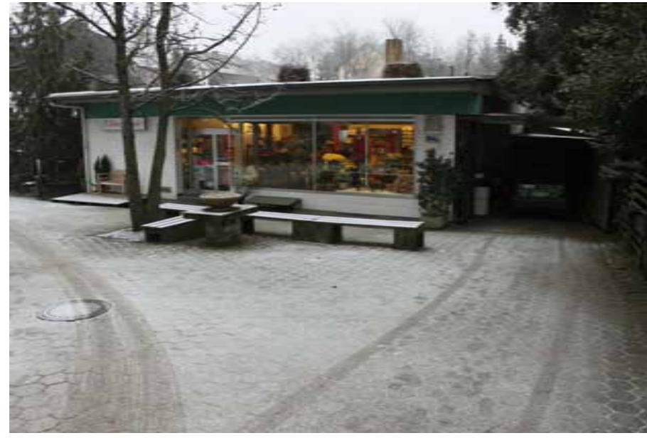
Foto Nr.1: Zufahrt, Ladenlokal
