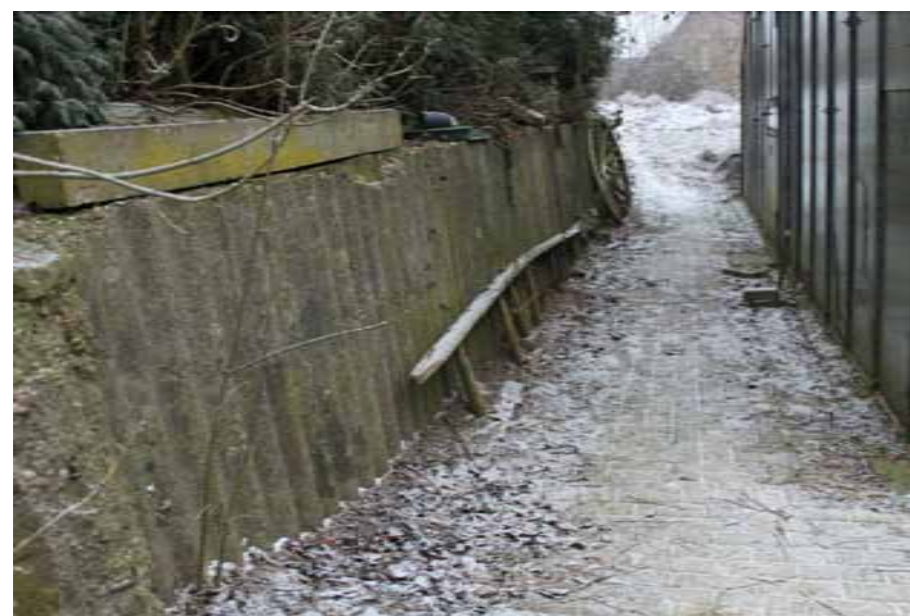
Foto Nr.16: Stützmauer südlich Gewächshaus IV
