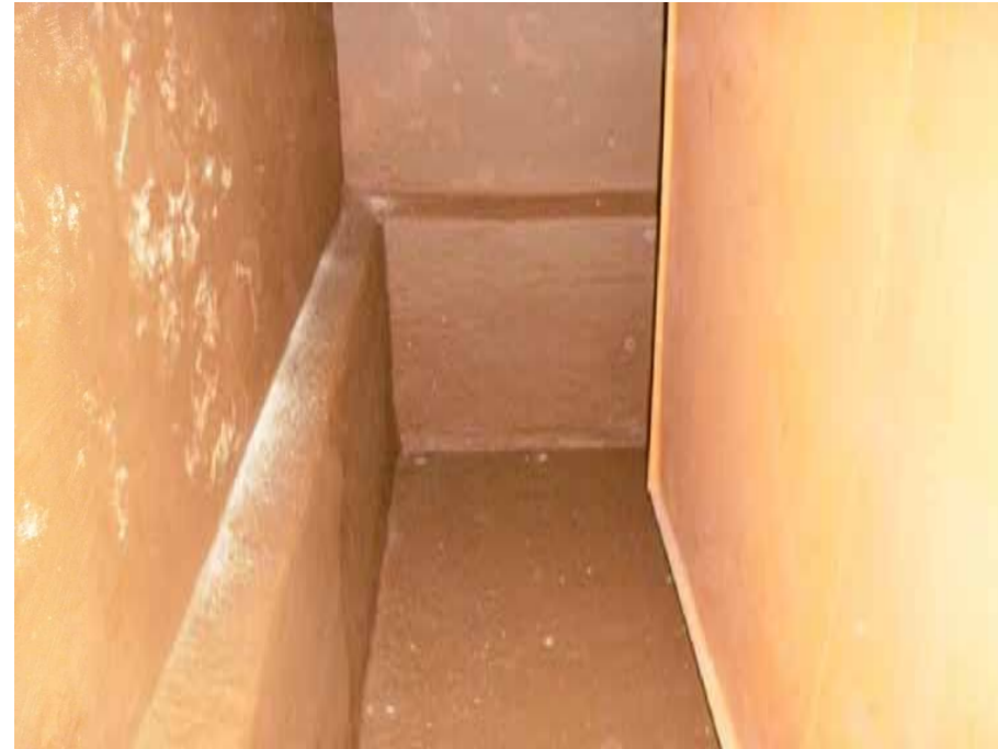
Foto Nr.6: Heizöltank im Keller
