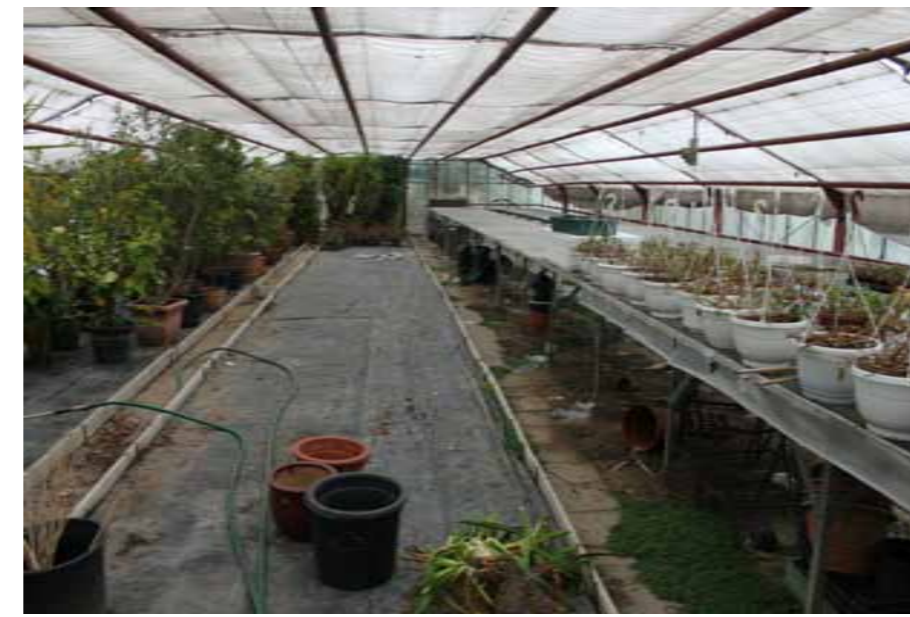
Foto Nr.13: Gewächshaus IV, Abstellflächen mit Asbestplatten
